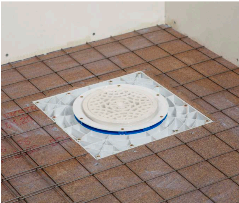
Foto 18. Underkantsarmering och monteringsplatta.
