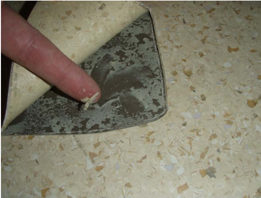
Foto 9. Nedbrytning av plastmatta och mattlim vid en skadeutredning på grund av fuktigt underlag.
