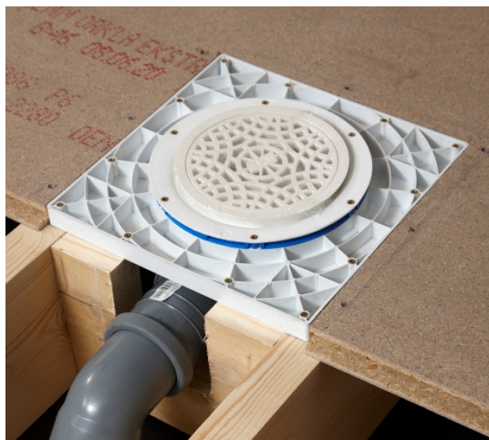
Foto 19. Monteringsplatta till golvbrunn.
