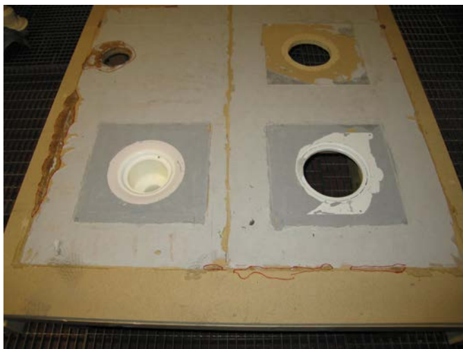
Foto 16. Exempel på läckage som upptäcks först när tätskiktsfolien demonteras.
