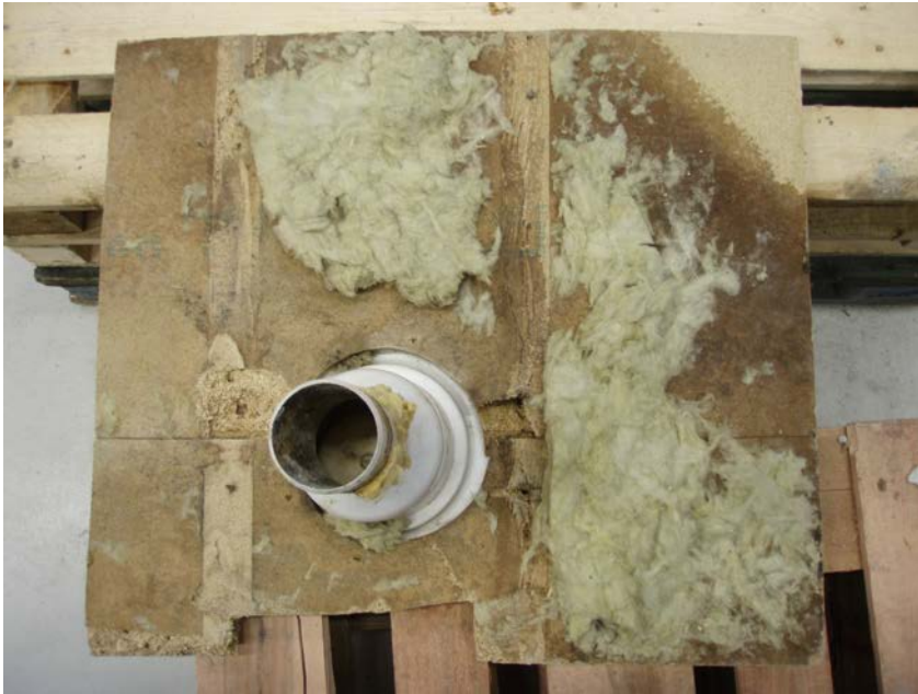
Foto 2. Inga kortlingar samt golvbrunn monterad i skivskarv.
