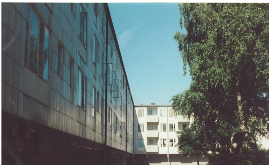
Bild 1: Växelmyntsgatan före renoveringen. Foto Sanja Peter, Göteborgs Stadsmuseum
